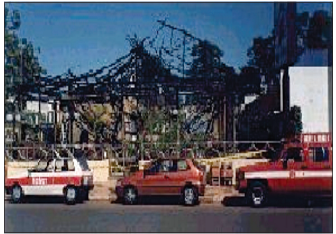
Figura 2: Incêndio em edificação com cobertura de fibras vegetais (ocupação de bar e restaurante)
